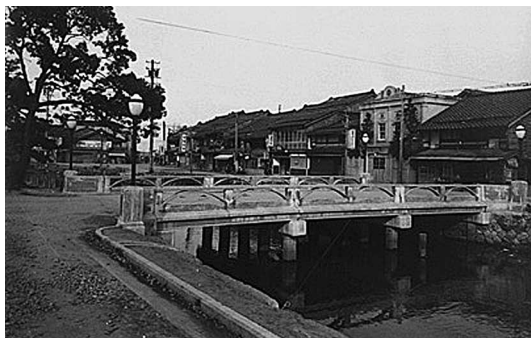
建設時の長生橋
