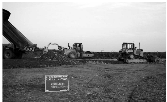
建設発生土盛土状況
