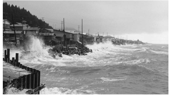
青森海岸今津地区(施工前)
