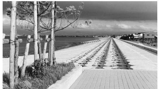
青森海岸西田沢地区(施工後)
