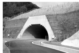
波子町RCCカルバート
