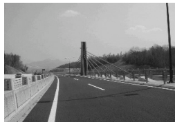
尺度橋 (エクストラード橋)
