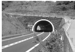
あぐる 大黒トンネル (現在は 期のみ施工)
