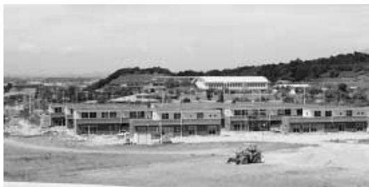
ハーモニー団地全景
