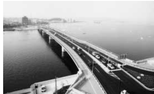
北側から望む宍道湖大橋
