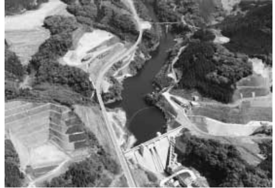
川辺ダム完成
