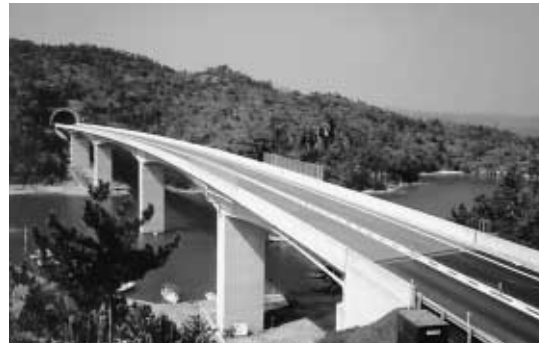
千蔵大橋と西の浦トンネル
