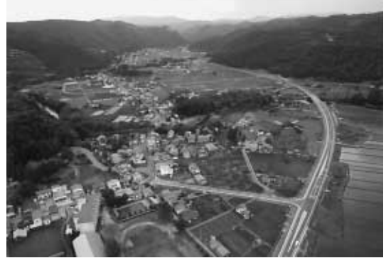
合川・似鳥工区全景（平成14年7月開通）
