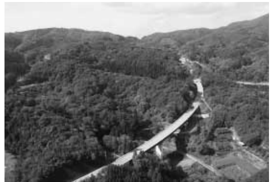
折爪工区全景（平成14年11月開通）
