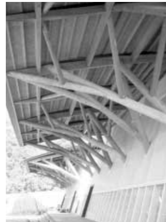
樹状立体トラス
