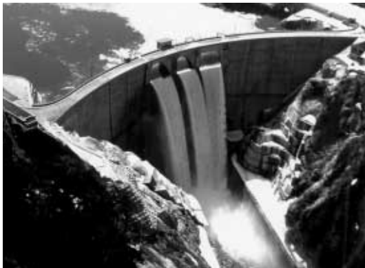
試験湛水中の奥三面ダム 貯水地の氷が融み放流水と共に流れ落ち、ようやく水面が見え始めた。(4月8日撮影)
