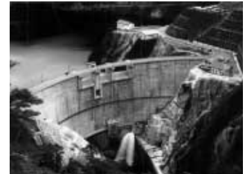
竣工式直前の奥三面ダム(試験湛水完了後、水位を徐々に上昇させている。)
