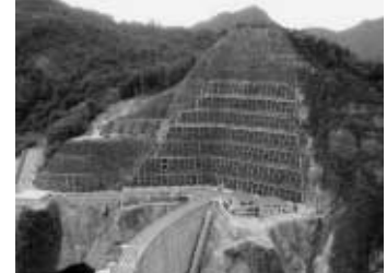
左岸側のり面保護(最下段は1年経過、上部は吹き付け後5年が経過。ようやく上部が、全面的に緑化され法枠が隠れ始めた。)
