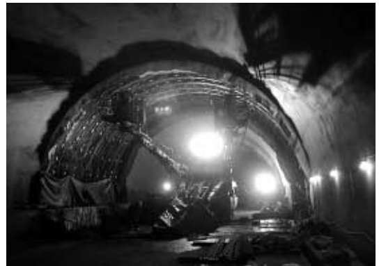
洞爺トンネルの施工状況
