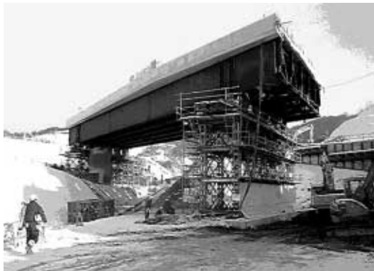
板谷沢橋の施工状況
