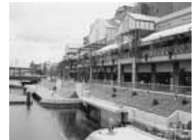
観察窓付近状況
