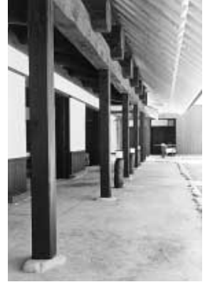
母屋軒下廻り：伝統的木造工法で架構を表わし、二重垂木で軒を深くしている。
