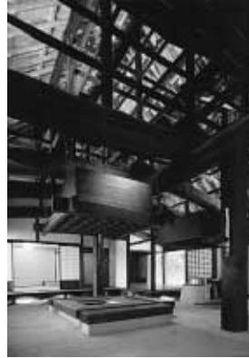
中世に見る日本の民家の小屋組（オダチ・トリイ組）を再現、囲炉裏・かまども設置
