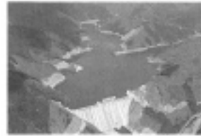
千屋ダム全景
