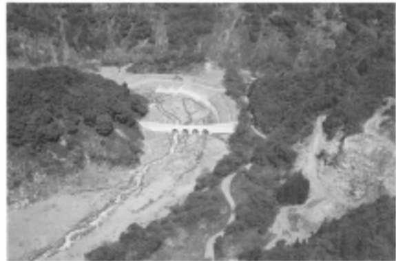
スーパー暗渠砂防堰堤全景（上流よりのぞむ）
