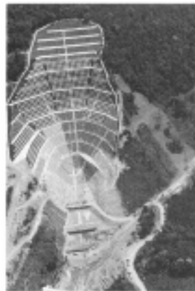
右岸山腹工(崩壊地)
