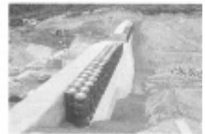
既設ダム(砂防施設災害復旧事業)
