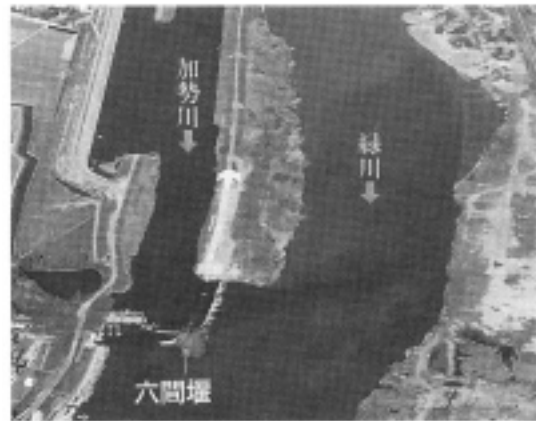
六間堰付近（工事着手前）
