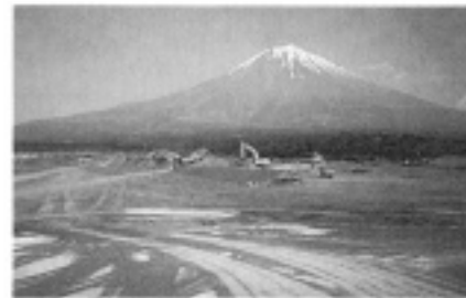
除石工（大沢扇状地）
