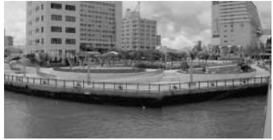
親水護岸及び身障者用のスロープ
