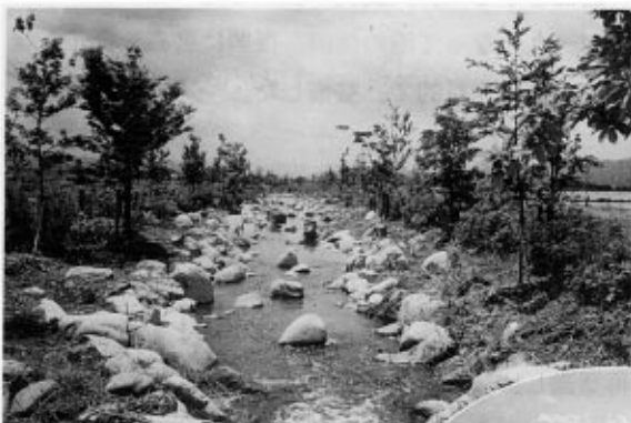
△ 多自然型水路
